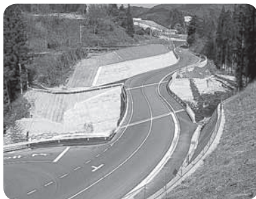
坪川橋架替事業がすべて完了しました。
