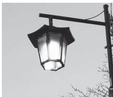
LED化された街路灯
