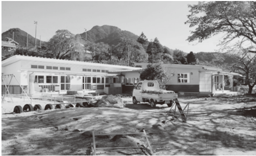
改修完了間近の田立保育園
