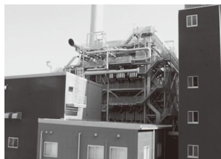
吾妻木質バイオマス発電所
