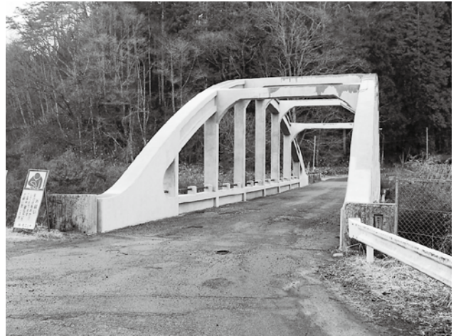
広瀬の本谷橋(長寿命化一部完了)
