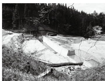
建設中の渡島蛇抜け沢堰堤
