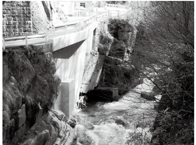
与川渡棧橋(長寿命化完了)
