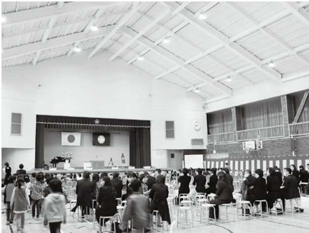
小学校体育館(つり天井の除去完了)
