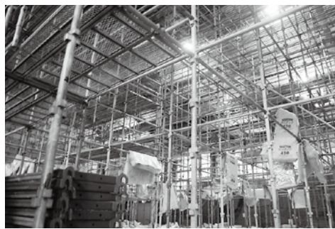
小学校体育館の天井工事。館内は足場がぎっしり
