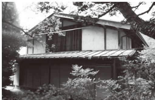
耐震化促進が待たれる木造住宅
