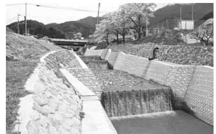
梨子沢橋下流の復旧完了
