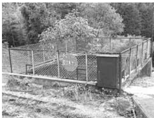
日々の管理が大切です（防火水槽）
