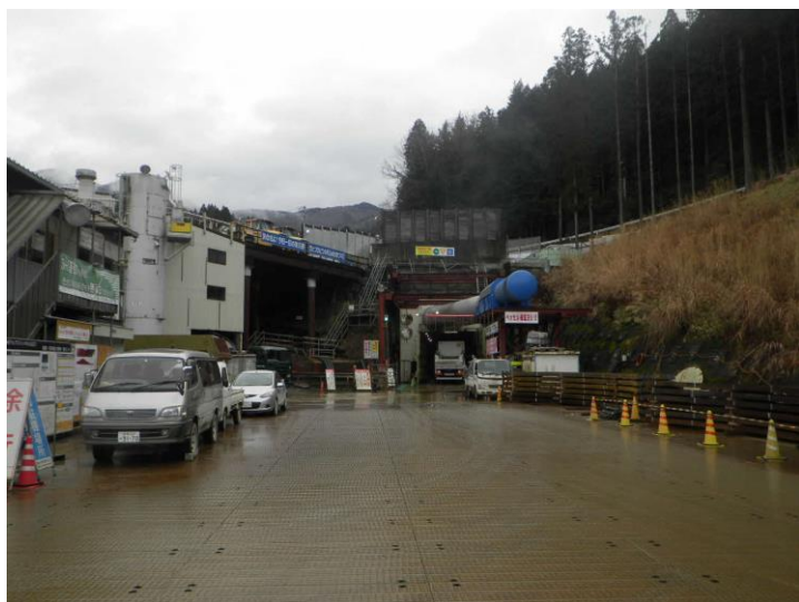
斜坑坑口状況 (R5.1撮影)
