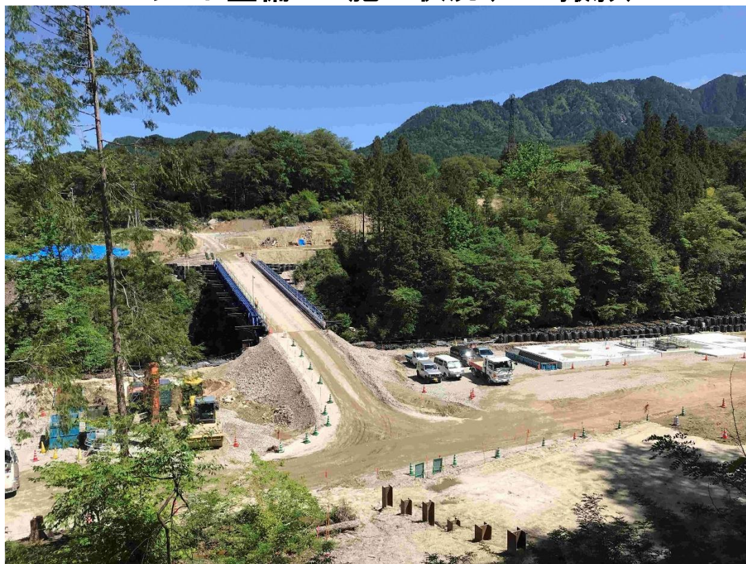
ヤード整備工 施工状況(R5.5撮影)
