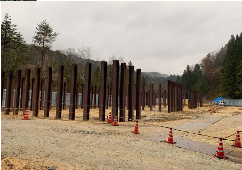
ヤード整備工 施工状況
