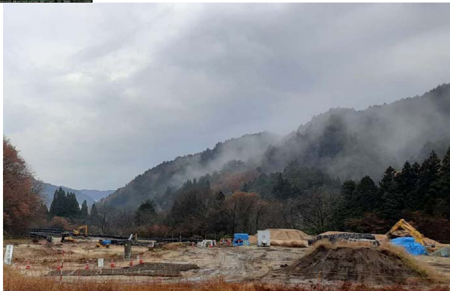
ヤード整備工 施工状況
