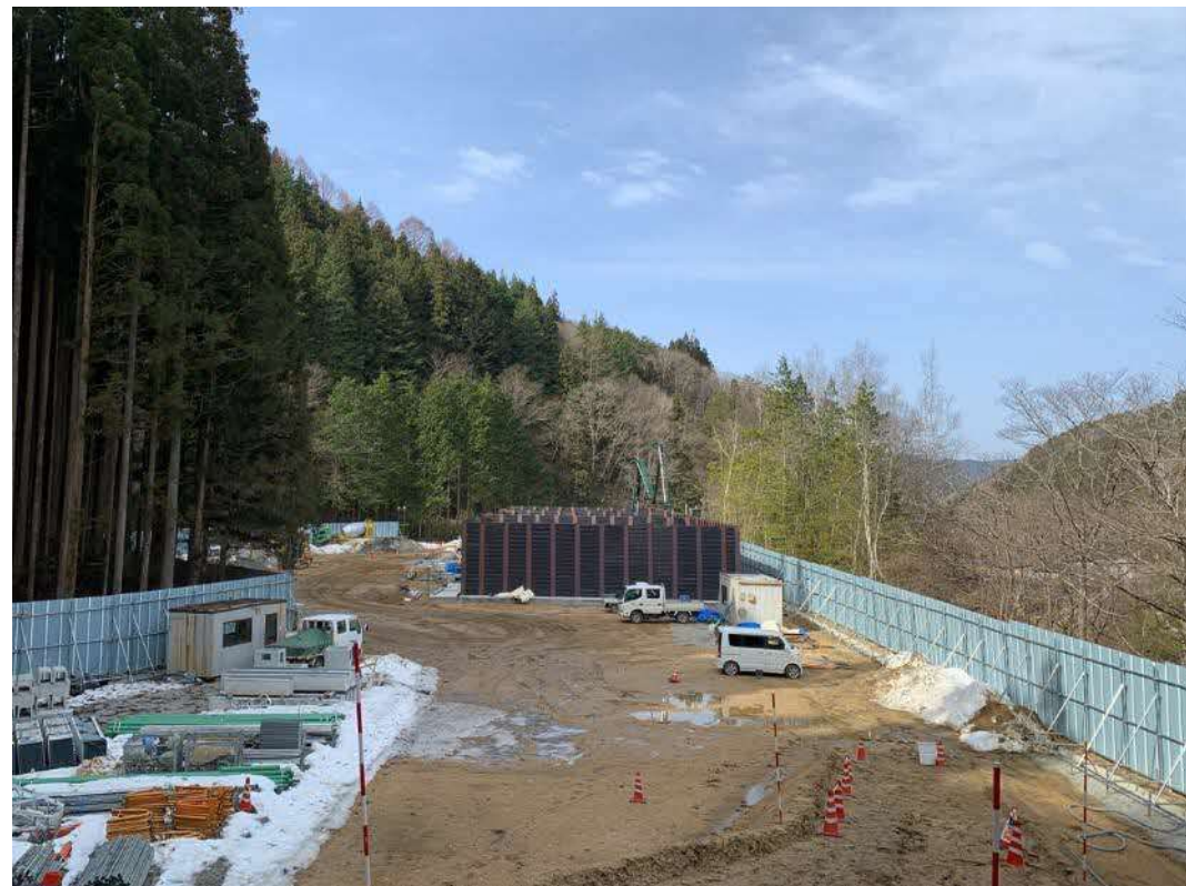
ヤード整備工 施工状況
