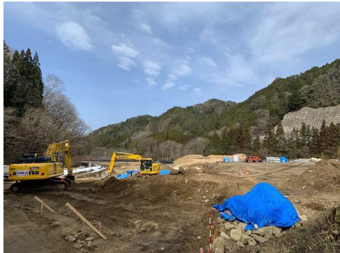
ヤード整備工 施工状況
