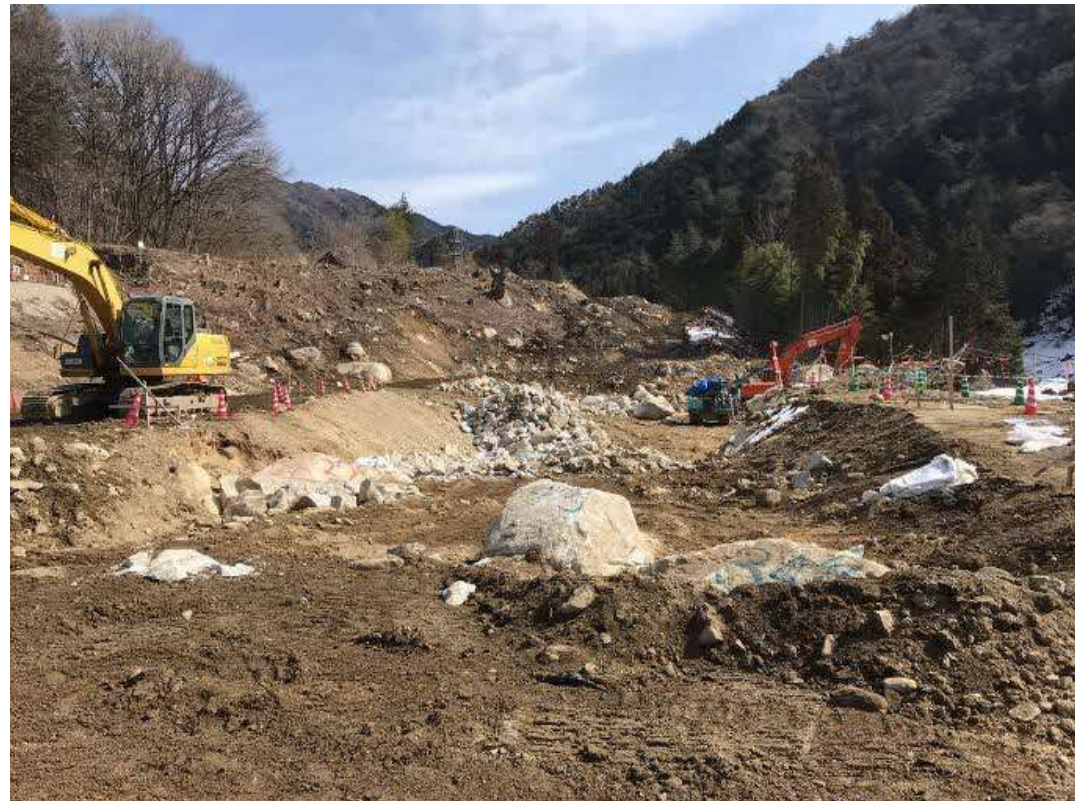
ヤード整備工(蘭川右岸) 施工状況
