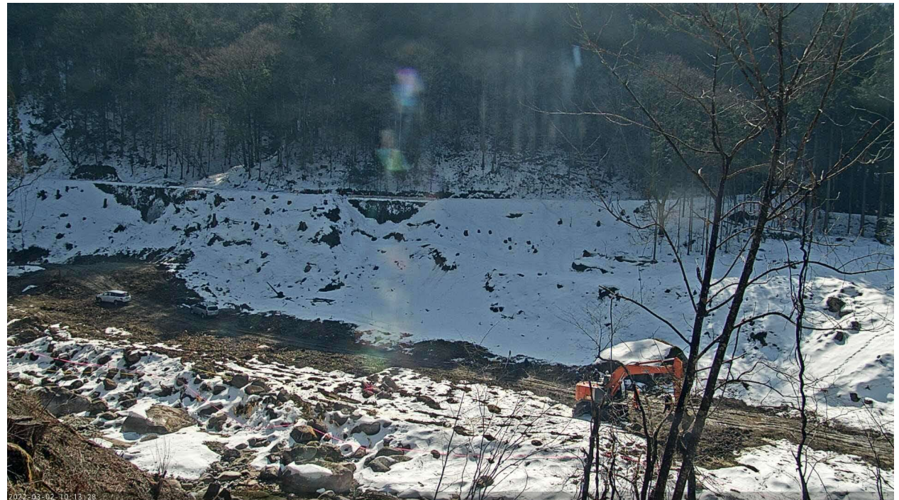
ヤード整備工(蘭川左岸) 施工状況
