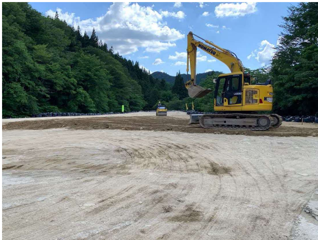
ヤード整備工 施工状況
