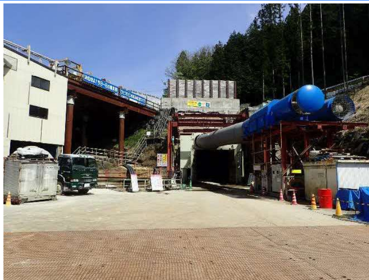
斜坑坑口状況
