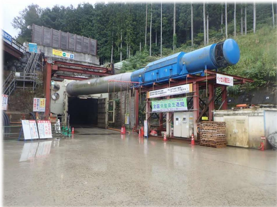
斜坑坑口状況 (R5.9撮影)
