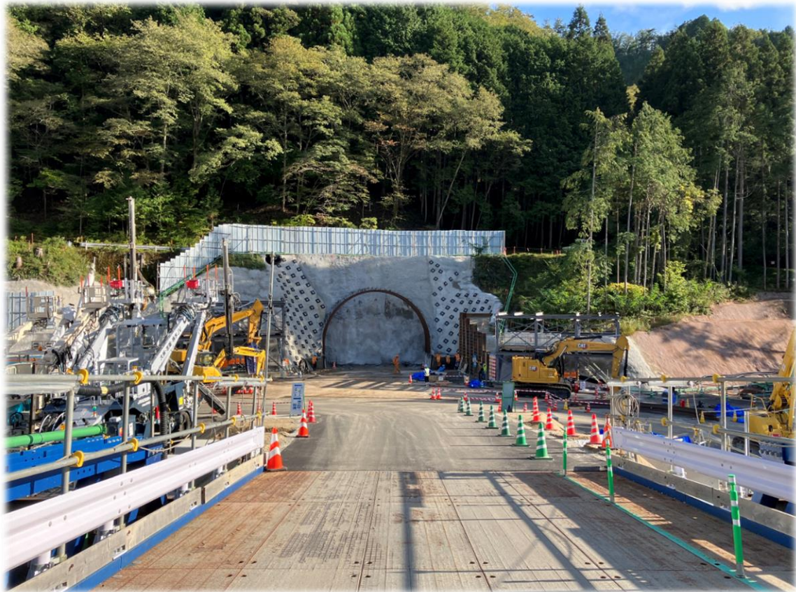
坑口付近施工状況 (R5.10撮影)
