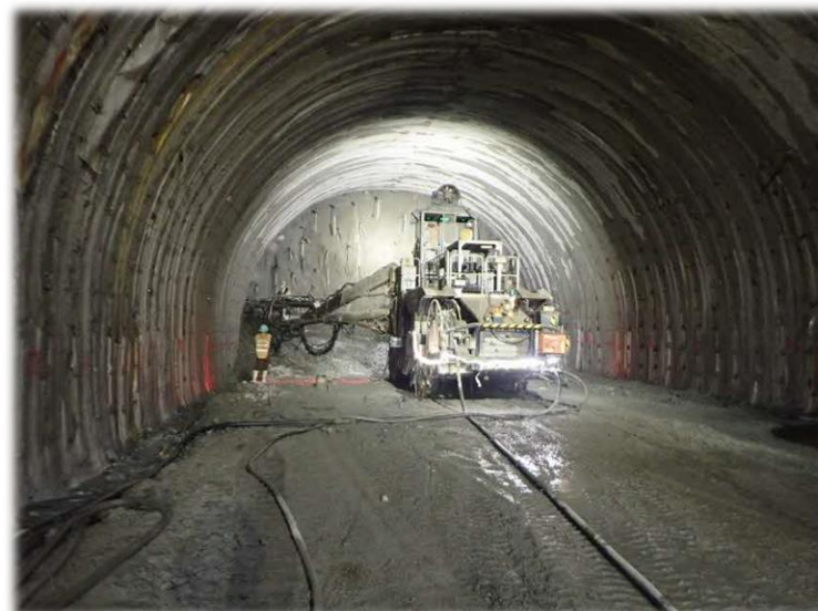
本坑 掘削状況 (R5.9撮影)
