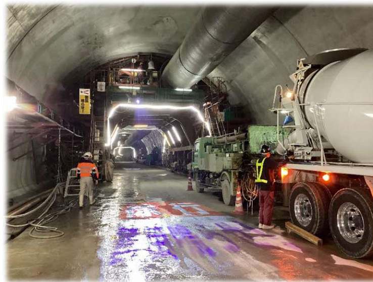
本坑 覆工コンクリート施工状況 (R5.9撮影) 5
