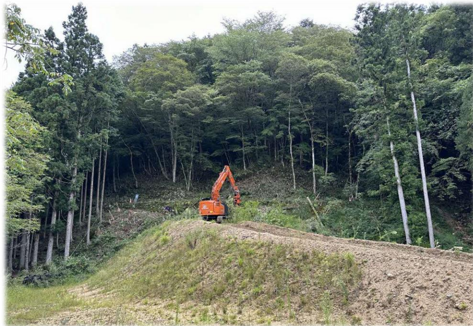
ヤード伐採工 施工状況 (R5.9撮影)
