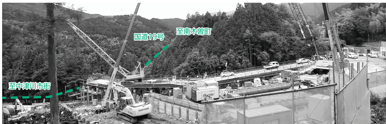
【H30.6.11時点 山口工区の状況】
