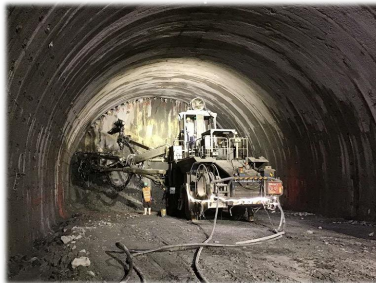
本坑 掘削状況 (R5.10撮影)
