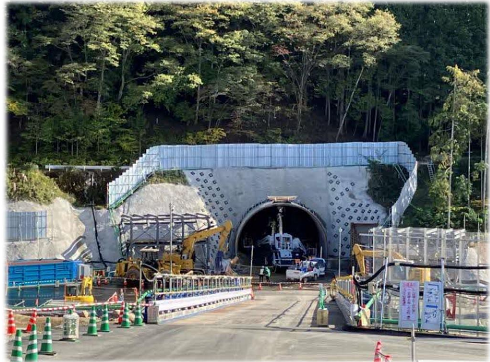
坑口付近施工状況 (R5.10撮影)
