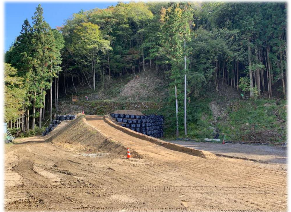
坑口上部法面工 施工状況 (R5.10撮影)
