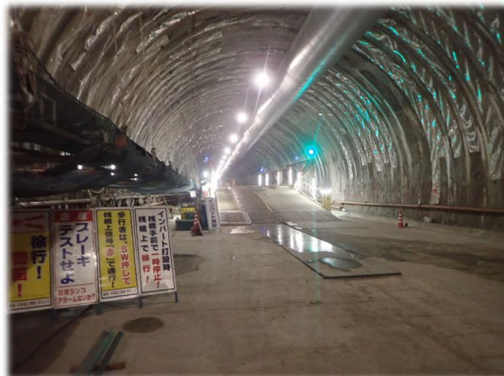
本坑 インバート施工状況 (R5.10撮影)
