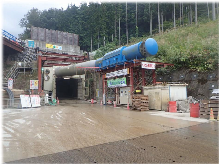
斜坑坑口状況 (R5.10撮影)
