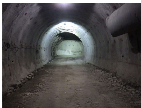
先進坑 (R5.1撮影)
