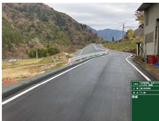
①町道改良完了状況 (R4.11撮影)
