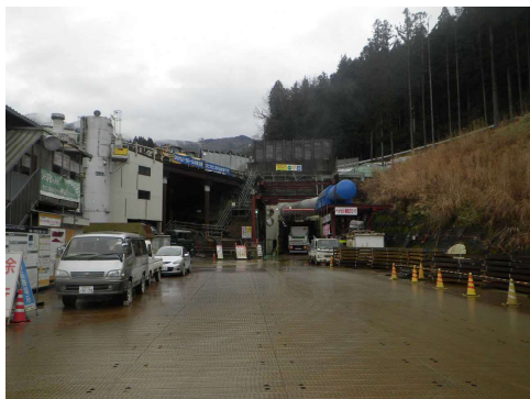
斜坑坑口状況 (R5.1撮影)
