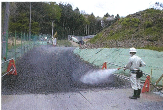
工事現場の散水状況
