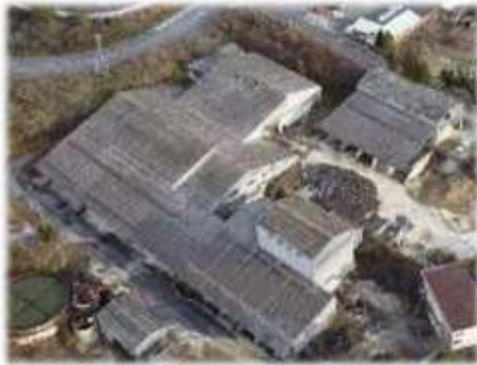
スレート(屋根・外壁)
