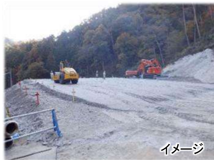
他工事での試験盛土の実施例
