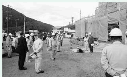
工事現場での説明
