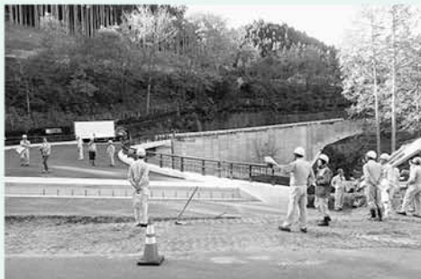
写真①：国道256号の工事状況 鍋割橋（新称）がほぼ完成
