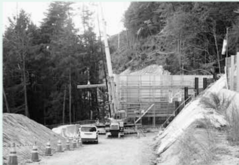
写真②：川向の右岸道路 工事中の「ませの洞橋」付近の状況
