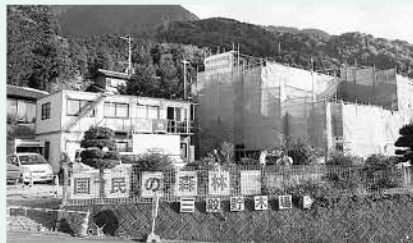
南木曽支署の新庁舎工事
