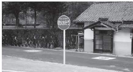
妻籠地区に設置された防火水槽
