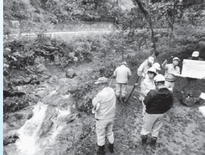
下り谷道路拡幅箇所を対岸から見学
