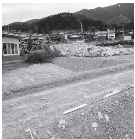
読書保育園の駐車場工事
