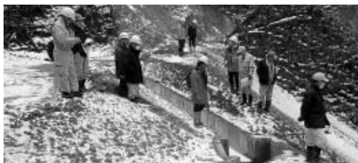
林道中ノ沢線開設現場
