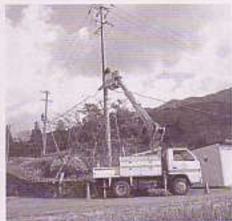
CATV工事が町内で行われています
