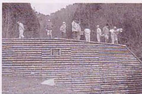
長者畑復旧治山工事現場を視察しました
