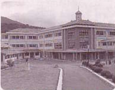
中学校の改築工事が一番大きな事業でした
