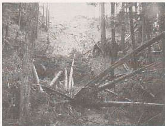
農業用水路の欠陥により土砂が崩落しました
