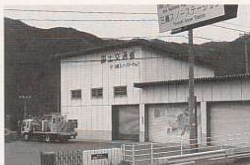
木曾町日義にある除雪ステーション
