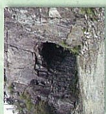
素掘トンネル
