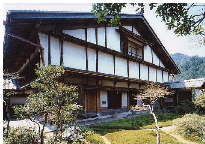
②8 建物北面
