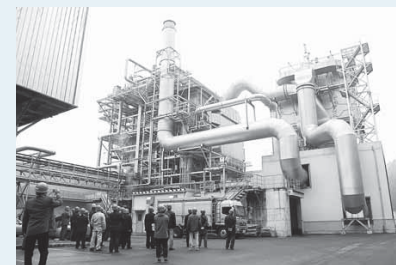
真庭市のバイオマス発電所
