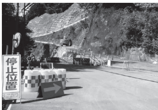
町道棚橋線改良工事（蘭広瀬線の片側通行）
