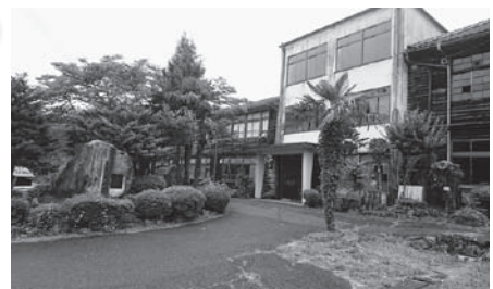
解体予定の旧妻籠小学校
