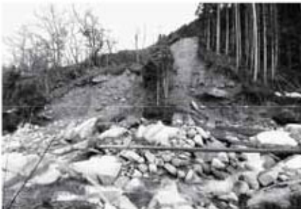
岩倉沢右岸の崩落箇所
