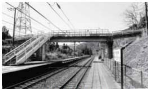
田立駅の町道の跨線橋
