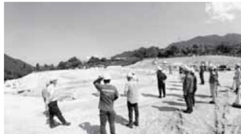
造成中の盛土全景
