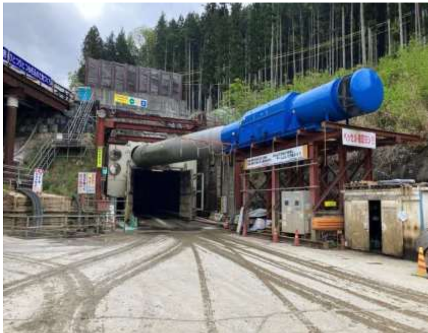
斜坑坑口状況(2026.4撮影)
