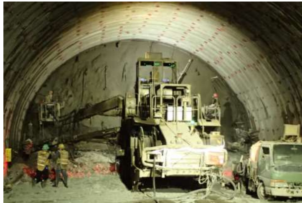
本坑掘削状況(2026.4撮影)
