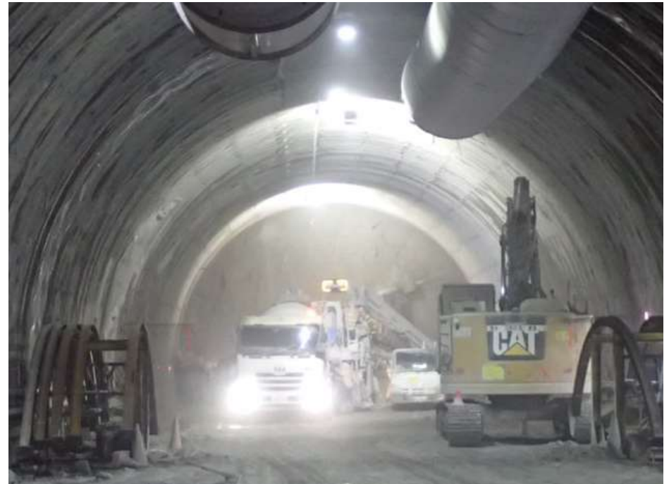
斜坑掘削状況 (2026.4撮影)
