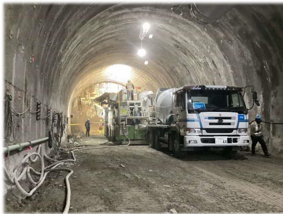
斜坑掘削状況 (R6.2撮影)
