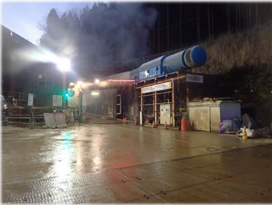
斜坑坑口状況 (R6.2撮影)
