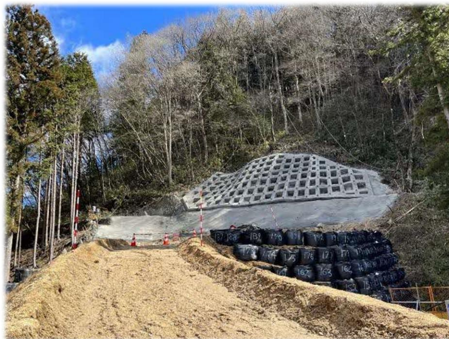
坑口上部法面工 施工状況 (R6.2撮影)
