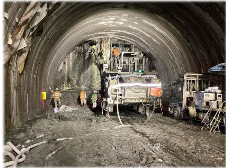
本坑 掘削状況 (R6.2撮影)
