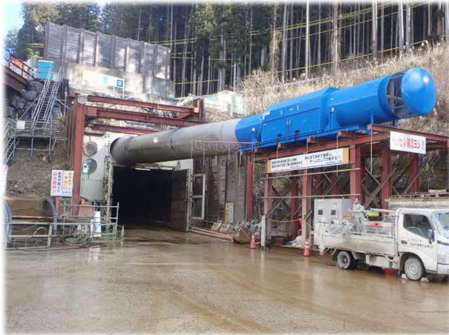
斜坑坑口状況 (R7.1撮影)
