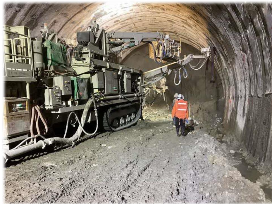
斜坑掘削状況 (R7.2撮影)
