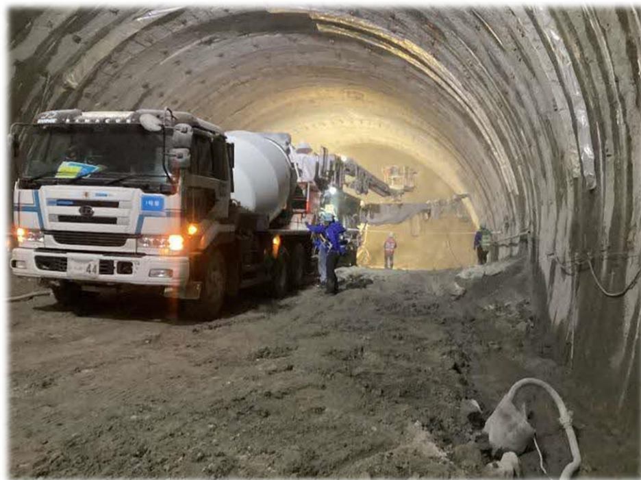
本坑掘削状況(R7.2撮影)
