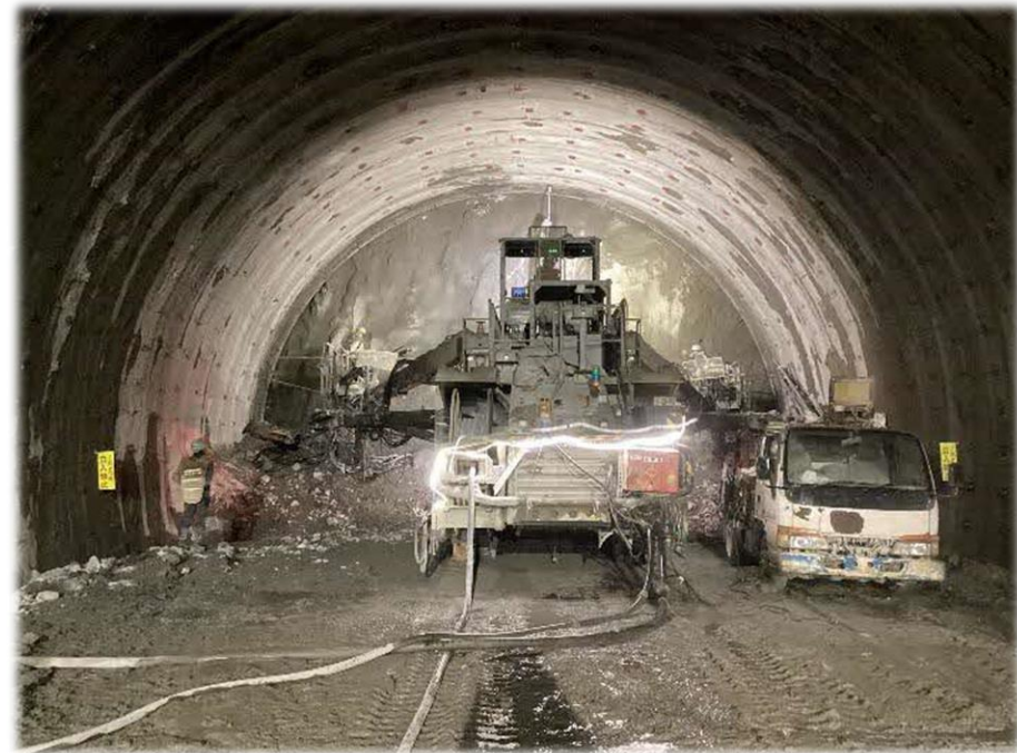
本坑 施工状況 (R7.2撮影)
