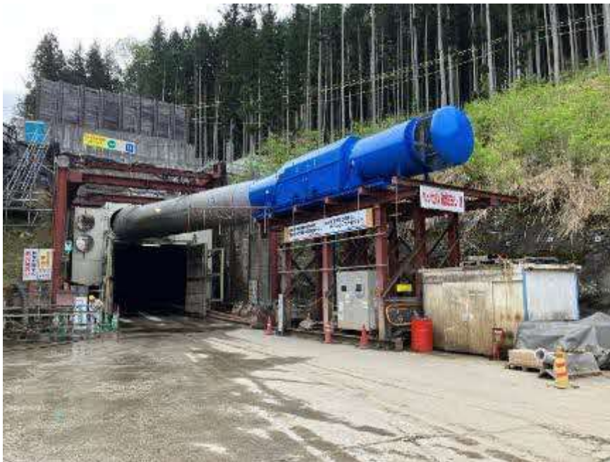
斜坑坑口状況 (R7.5撮影)
