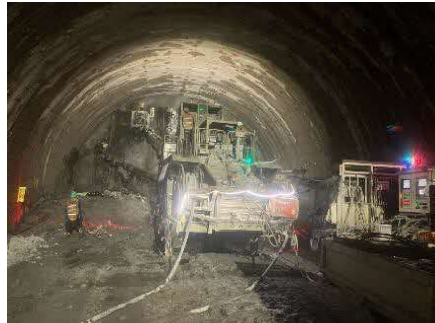
本坑 施工状況 (R7.6撮影)
