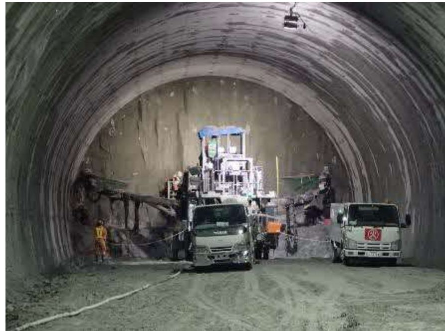
本坑掘削状況(R7.6撮影)
