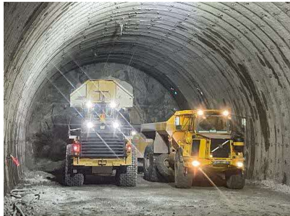
斜坑掘削状況 (R7.6撮影)
