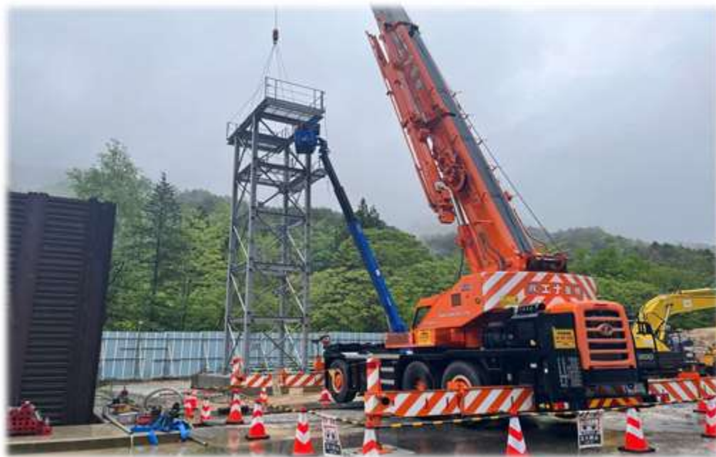
トンネル仮設備 施工状況 (R6.5撮影)
