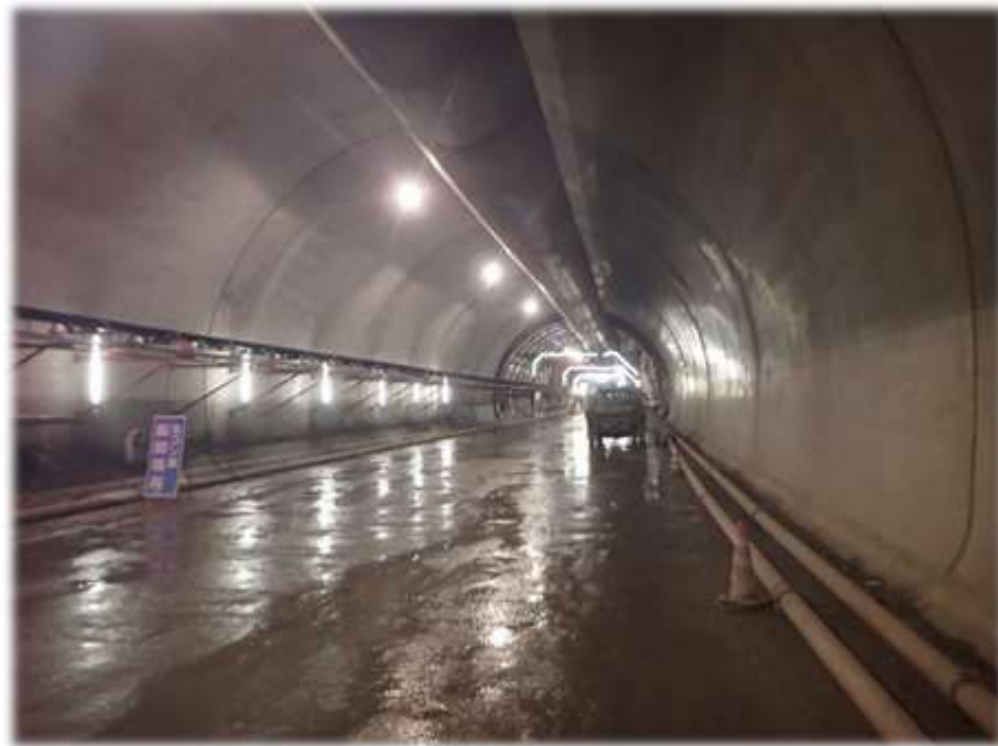
本坑 施工状況 (R6.4撮影)
