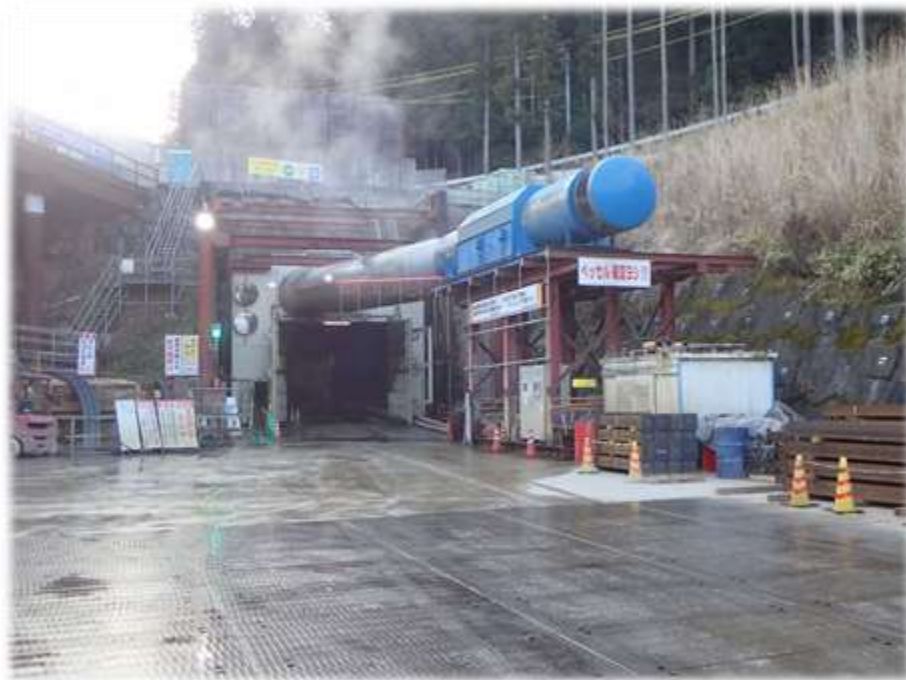
斜坑坑口状況 (R6.2撮影)
