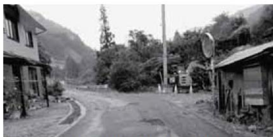
神橋の道路工事とバスの代行
