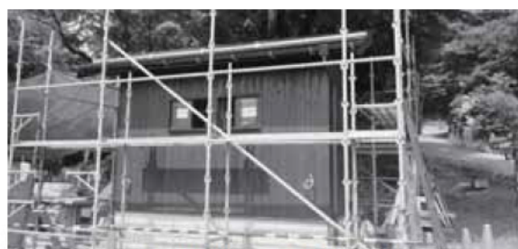
かぶと観音のトイレ工事
